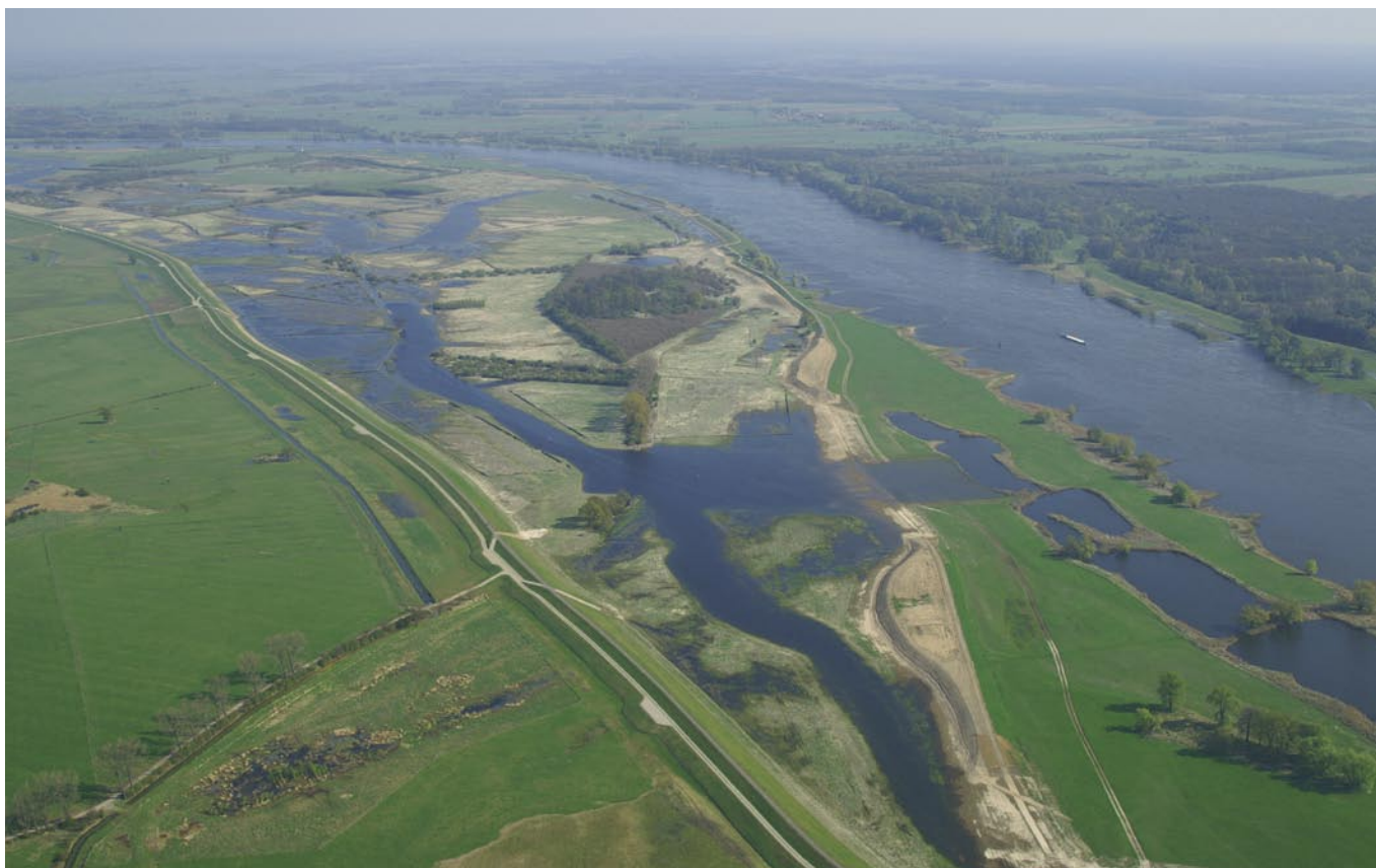
Deichrückverlegung an der Elbe bei Lenzen. Ein wegweisendes Projekt zur Verknüpfung von Hochwasserschutz, Gewässerentwicklung und Naturschutz an Bundeswasserstraßen. Foto: Katharina Nagel, BUND / Trägerverbund Burg Lenzen e.V.
