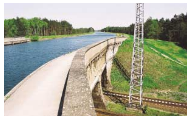
Künstlicher Gewässerabschnitt: Blick auf die Trogbrücke über die Bahnlinie am Oder-Havel Kanal bei Eberswalde
