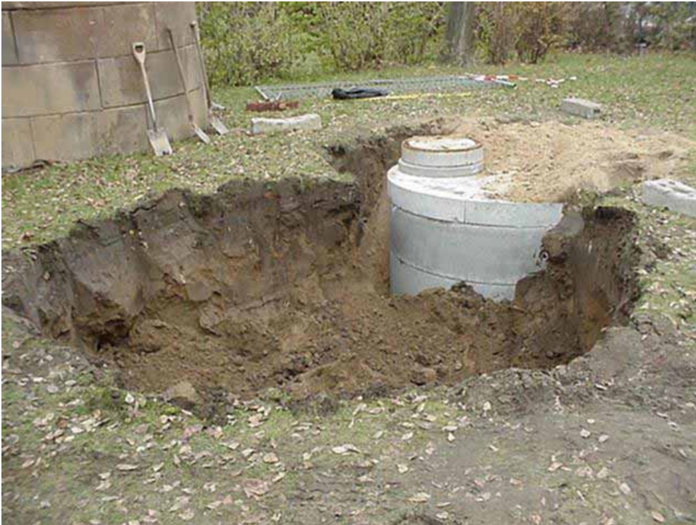
Einbau Sickerschacht
