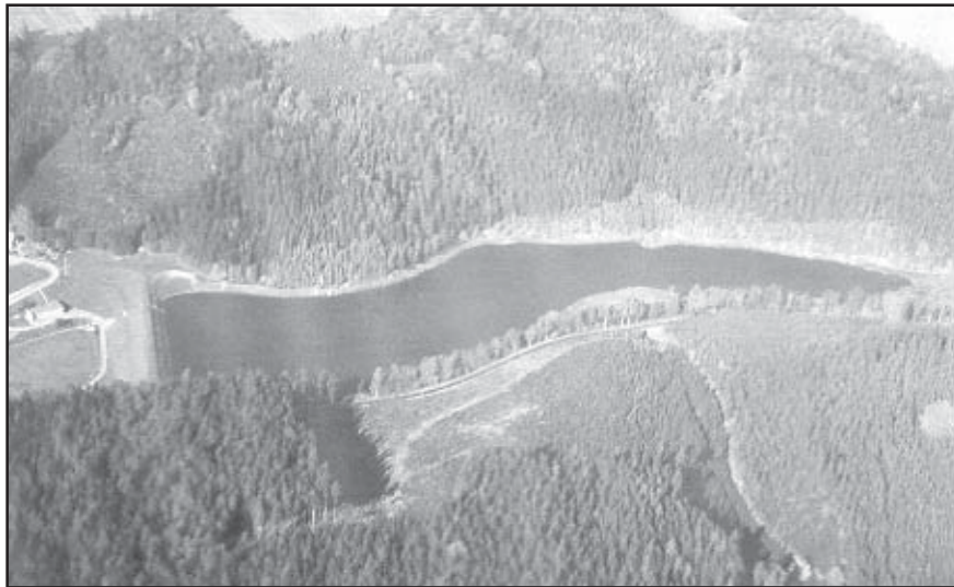
Luftaufnahme der Talsperre Krebsbach (Quelle: Mehlhorn et al., 2005)
