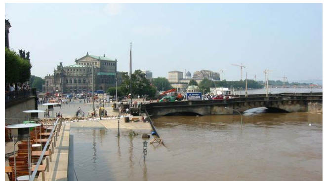
Elbehochwasser 2002 in Dresden, Augustusbrücke Quelle: www.kadner.online.de
