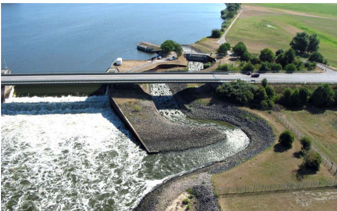
Für die Ökologie der Elbe von herausragender Bedeutung ist der Bau einer zweiten Fischwechsellanlage am Wehr Geesthacht. Die Errichtung einer Wasserkraftanlage in diesem Wehr hätte katastrophale Auswirkungen auf die Fischfauna im gesamten Elbeeinzugsgebiet. Foto: Wassergütestelle Elbe
