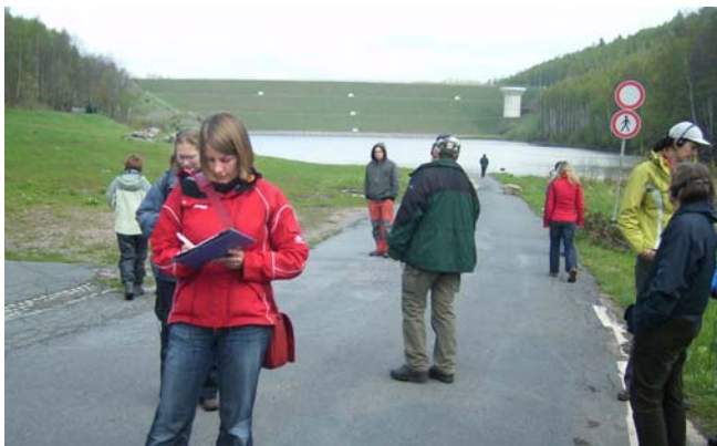
Hochwasserrückhaltebecken mit 40-m-Damm bei Lauenstein – Kein Beitrag zur ökologischen Durchgängigkeit. Foto: Michael Bender
