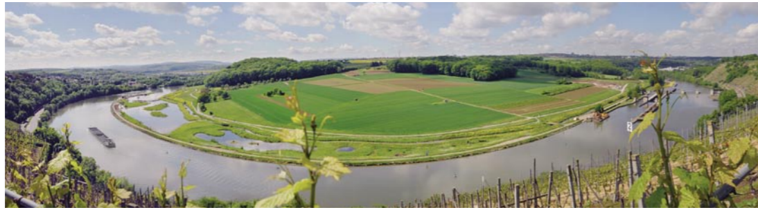
Dass sich moderner Schiffsverkehr mit ökologisch hochwertigem Uferbau verträgt, zeigt das Neckarbiotop Zugwiesen. – Foto: BMVI
