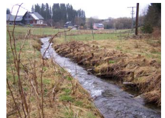
(2) Faschinen zum Schutz des Strommastes
