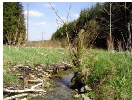
(4) Faschinen zur Lenkung der Strömung
