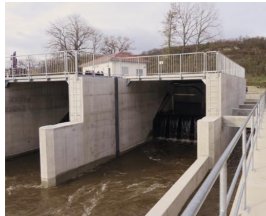
Turbinenauslauf Fischaufstiegshilfe
