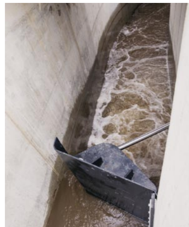
Bypass mit Klappe Öblitz
