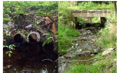
(4) Der Rohrdurchlass am Weierbach wird „durchlässig“
