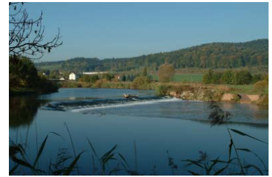
(2) vor dem Umbau zur Durchgängigkeit des Sallmannshausener Wehres (2003)
