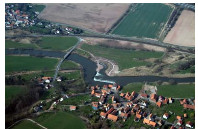
(3) Luftbild (2007) nach dem Umbau des Sallmannshausener Wehres
