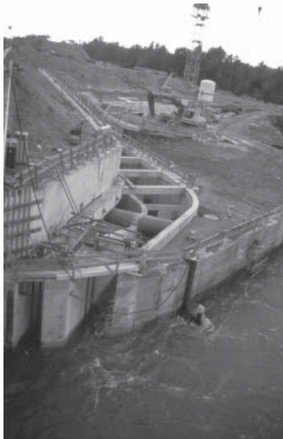
Der Bau des Fischpasses an der Staustufe Iffezheim am Oberrhein.
