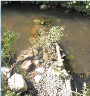
Strömungsenker aus Geröll und Gehölzschnitt
