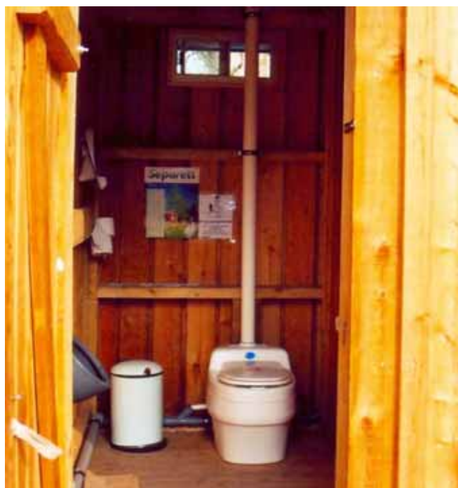
Separations-Trockentoiletten kommen ohne Wasseranschluss aus
